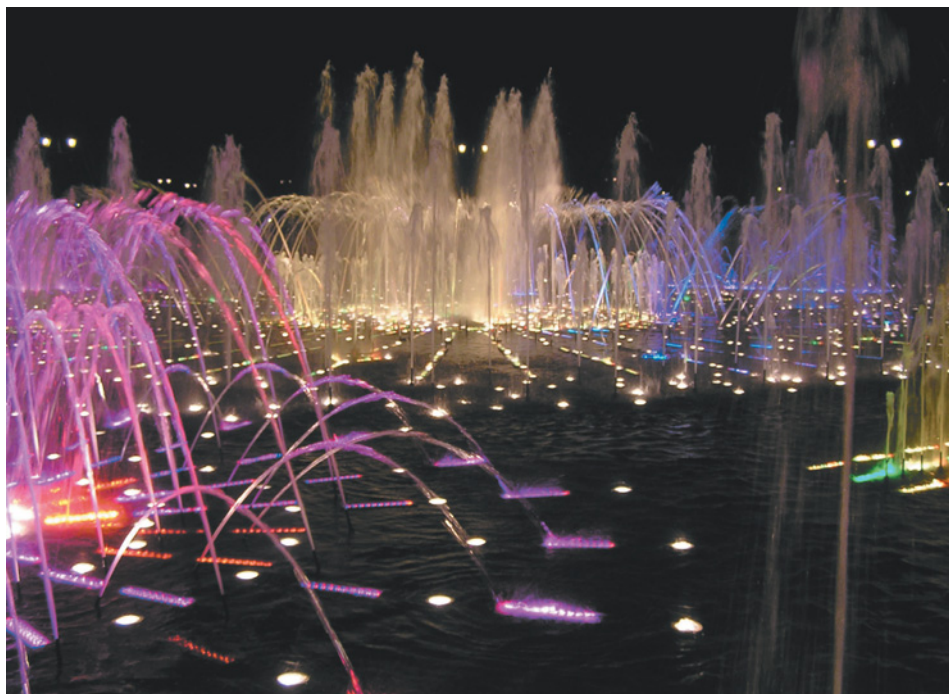
Рис. 6.2. Автоматическое управление светомузыкальными фонтанами
