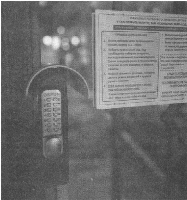
Рис. 3.6. Кодовый замок на калитке и инструкция для посторонних
