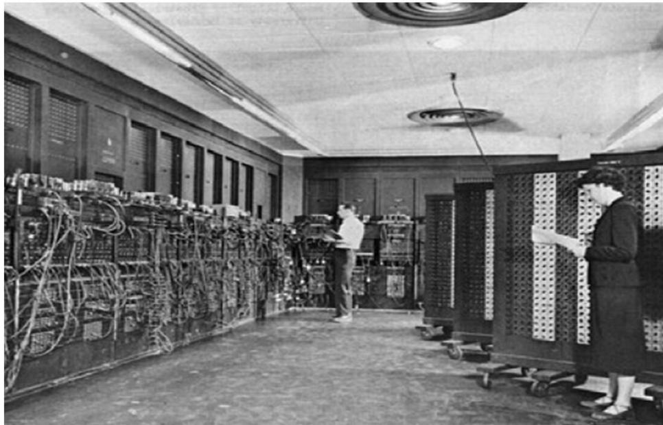
Как вы можете видеть на этом слайде, ENIAC был большой машиной, которая весила более 30 тонн, содержала приблизительно 18000 вакуумных трубок, и размещалась в большой комнате 180 квадратных метров.
