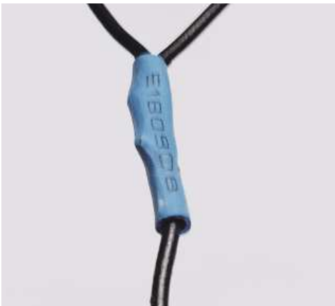
Рис. 10.19. Объедините заземляющие провода в один
